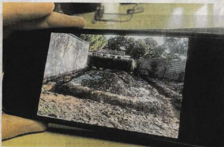
Dans le jardin de l'un des membres du collectif, les fondations creusées d'un garage sont restées telles quelles.
